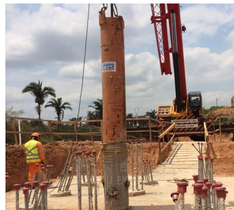
Ensaio em estaca hélice contínua
