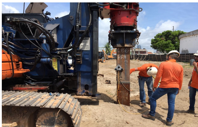
Ensaio em estaca metálica
